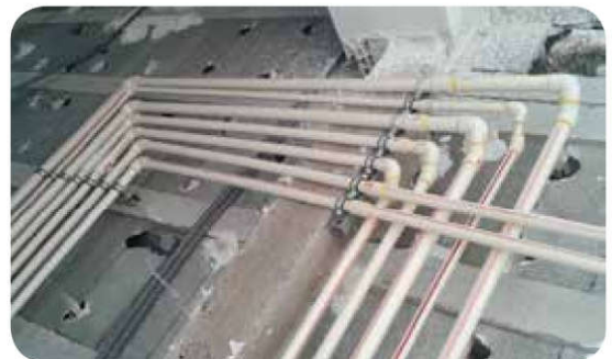
Exemple de tuyaux FLOWGUARD TM CPVC avant le coulage du béton.
